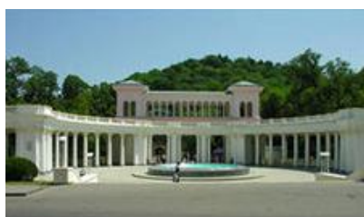
Центр города. Колоннада. 15 мкР/ч
